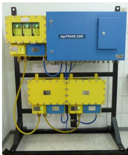
Montiran lastno varni napajalnik NSB3 v sistemu
